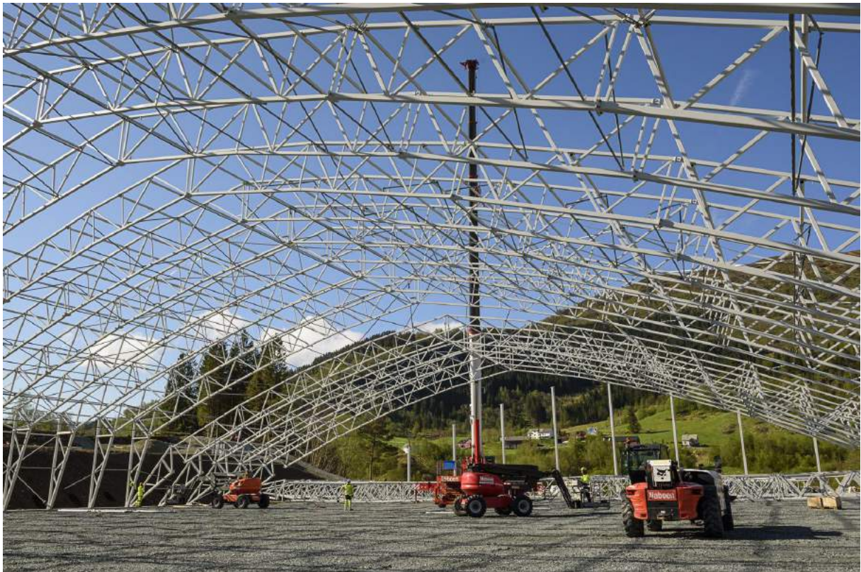
Kaldhallen. Foto: David Zadig
